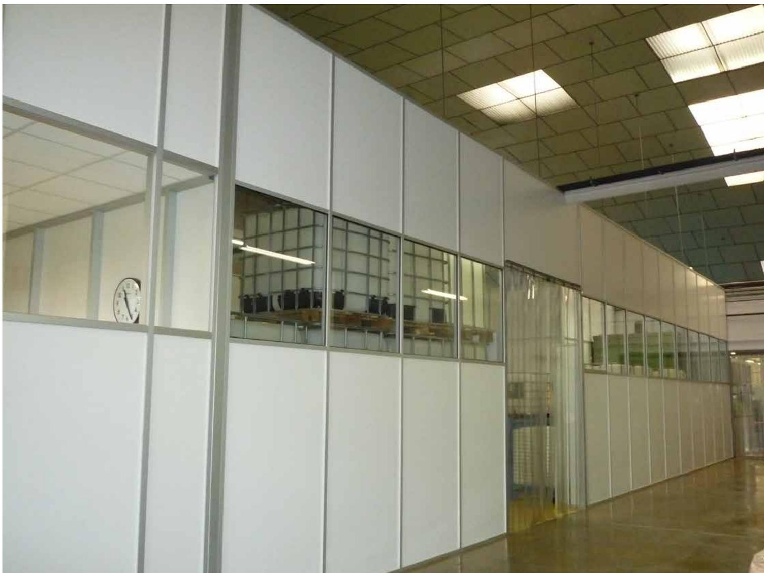
Perfil extrusionado de 75mm lacado o anodizado que forma una mampara de doble cara rellena con lana de roca mineral ecológica para lograr un óptimo aislamiento termoacústico. Posibilidad de instalar cortinas interiores accionadas con un botón instalado en la misma perfilaría.
